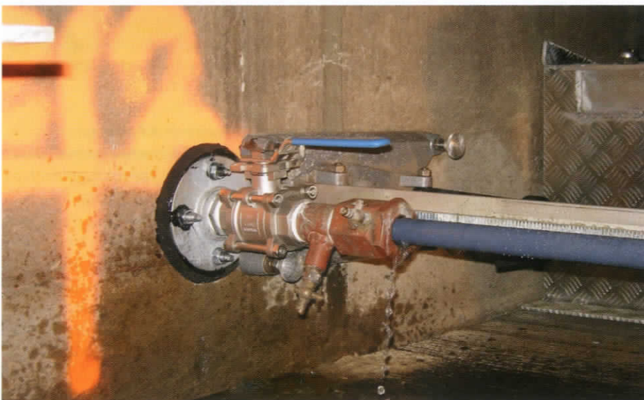
Figuur 6: Aanbrengen van één van de infiltratiepunten
